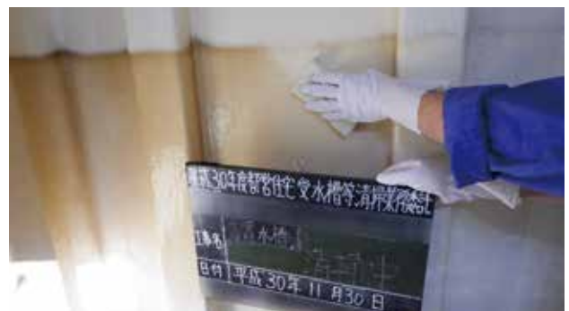
貯水槽の中、汚れをこすって落としていきます
