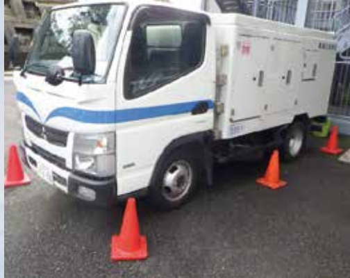
高圧洗浄車と繋がったホースで配水管を清掃します
