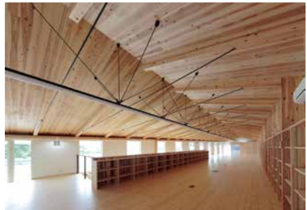
全面 CLT 材の内装
